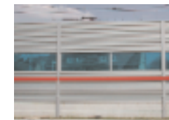
Schallschutzwände zählen zu den aktiven Lärmschutzmaßnahmen
